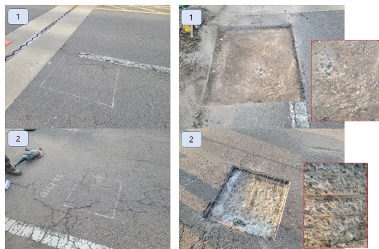
[그림 4-26] 압구정고가 1차로 420~480m 구간 부분 절삭 결과
