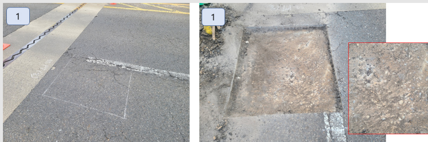
【그림 7】 압구정고가 2차로 420~480m 구간 부분절삭 결과
